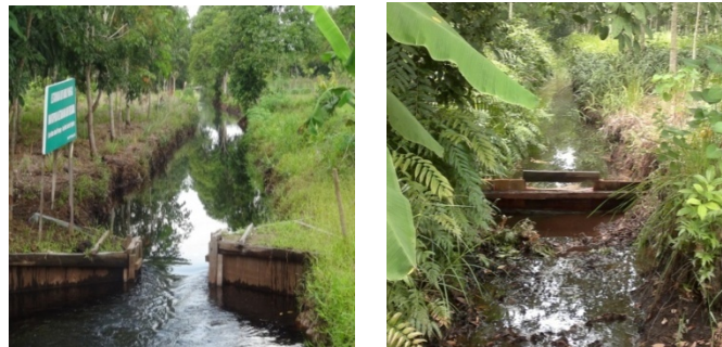
Gambar 15. Pengelolaan air sistem tabat di Desa Jabiren, Kalimantan Tengah
